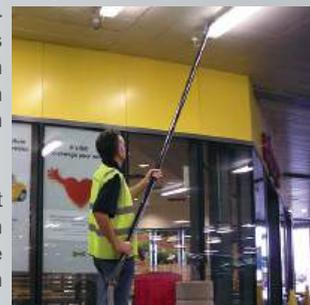
Optional wird eine Kamera mit Monitor angeboten, damit man die Arbeit verfolgen und eine optimale Reinigung sicherstellen kann
